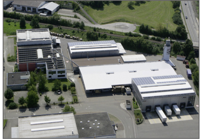
Unternehmensgelände (42.000 m 2 ) mit einer Photovoltaikanlage auf einer Dachfläche von rund 1.500 m 2 .
